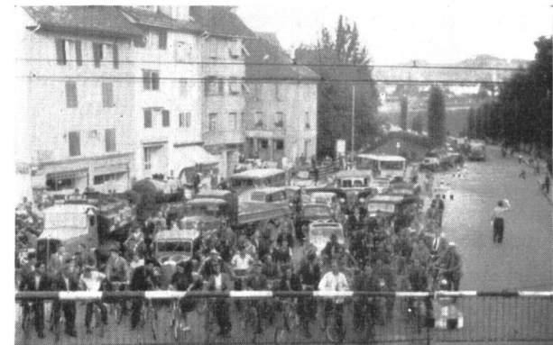
Abb. 16. Die Polizei muss die rechte Platzhälfte für den Verkehr, der in entgegengesetzter Richtung fliesst, freihalten.
