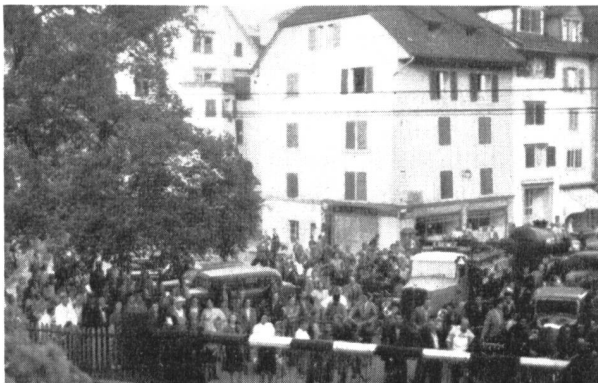
Abb. 15. Die geschlossenen Bahnschranken bewirken eine Stauung des Lokal- und Durchgangsverkehrs.
