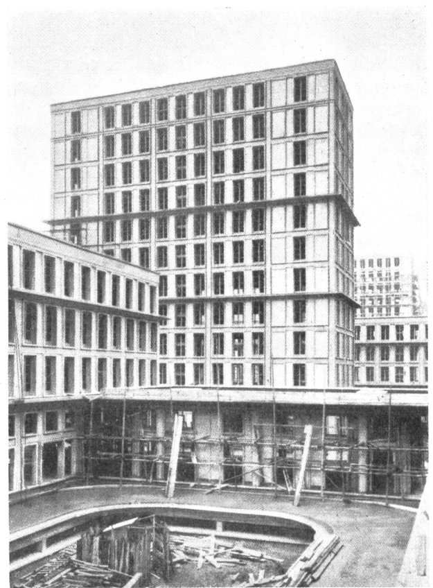
Abb. 10. Hochhaus aus dem Wiederaufbau des Zentrums von Le Havre, 1950, im Bau, Arch. A. Perret.
