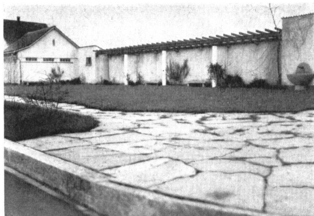
Abb. 3. Die Anlage von der Strasse her gesehen.
