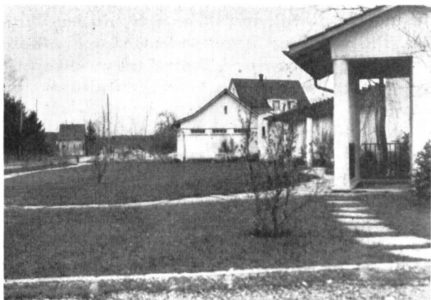
Abb. 1. Das Pumpwerk der Kläranlage ist mit einer öffentlichen Anlage verbunden und in Maßstab und Haltung sorgfältig in die Umgebung eingepasst.
