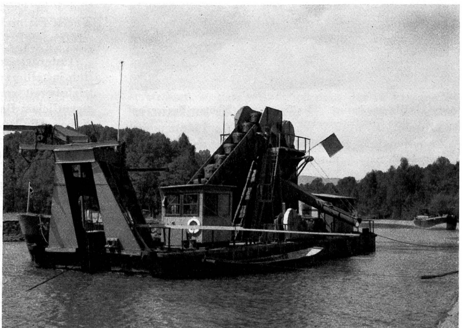
Abb. 17. Der grosse Eimerketten-Schwimmbagger Herkules.
