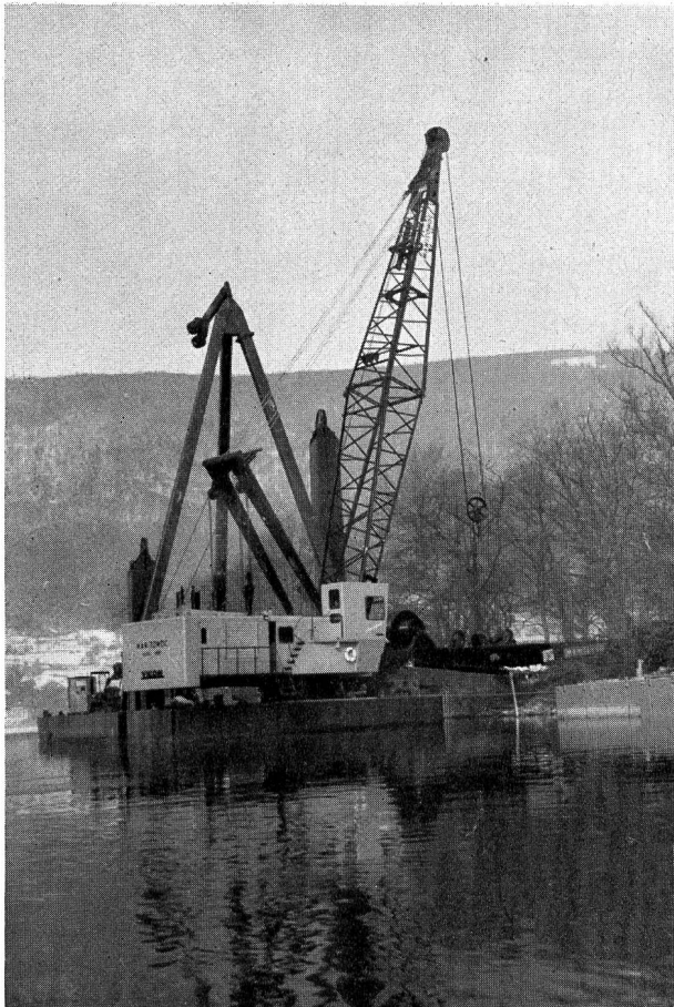
Abb. 20. Der «Manitowoc» bei der Fertig-Selbstmontage im Kanaleinlauf am Bielersee. Links und rechts die beiden lotrechten Seitenspuds von je 20 m Länge, Querschnitt 1,1 \times 1,1 m.
