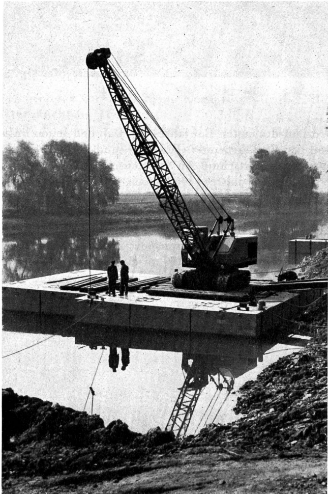
Abb. 18. Die modernen «Flexifloat» mit Montage-Bagger auf dem Installationsplatz in Brügg.
