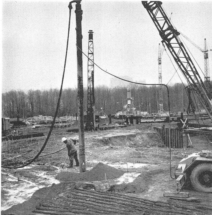
Tiefenverdichtung nach dem **RDV** für mehrere Klärbecken zur Reduktion der Wasserdurchlässigkeit
