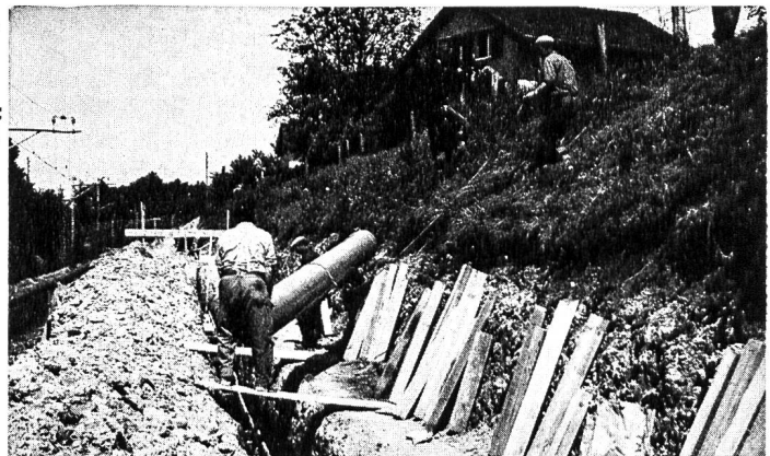
KALIDUR-Kanalisationsrohre, verlegt im Bahneinschnitt
