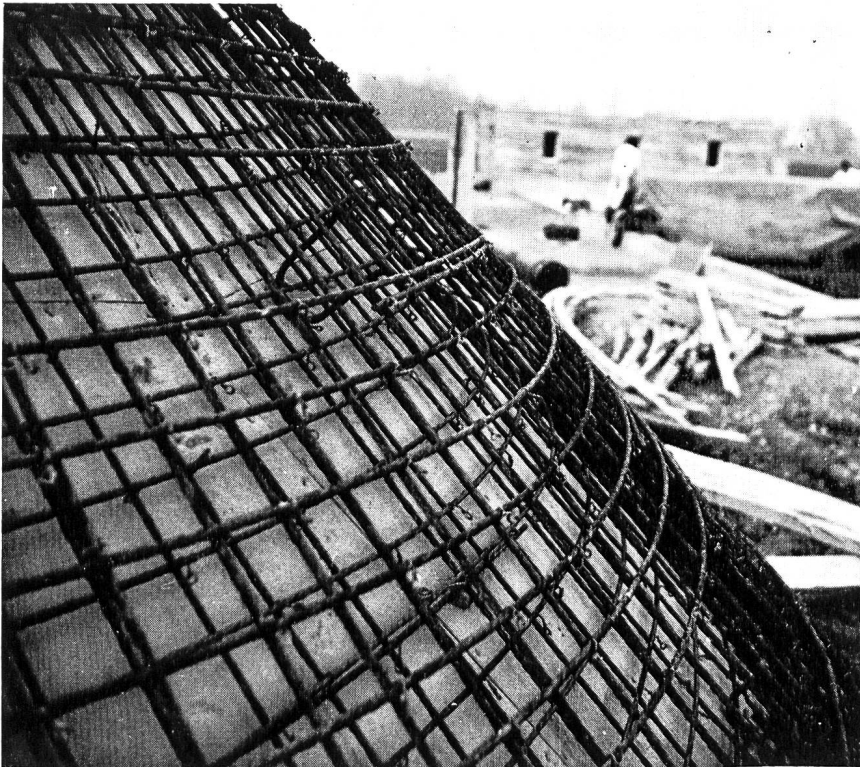
Abb. 2. Stahlarmierung auf Airex® verlegt.
