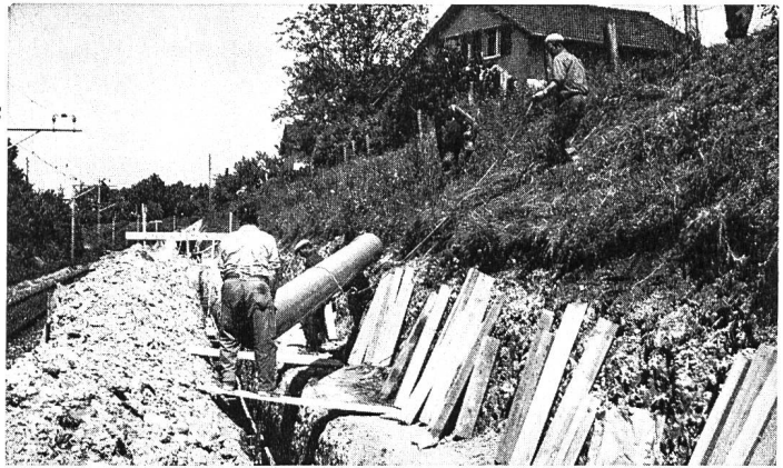
KALIDUR-Kanalisationsrohre, verlegt im Bahneinschnitt
