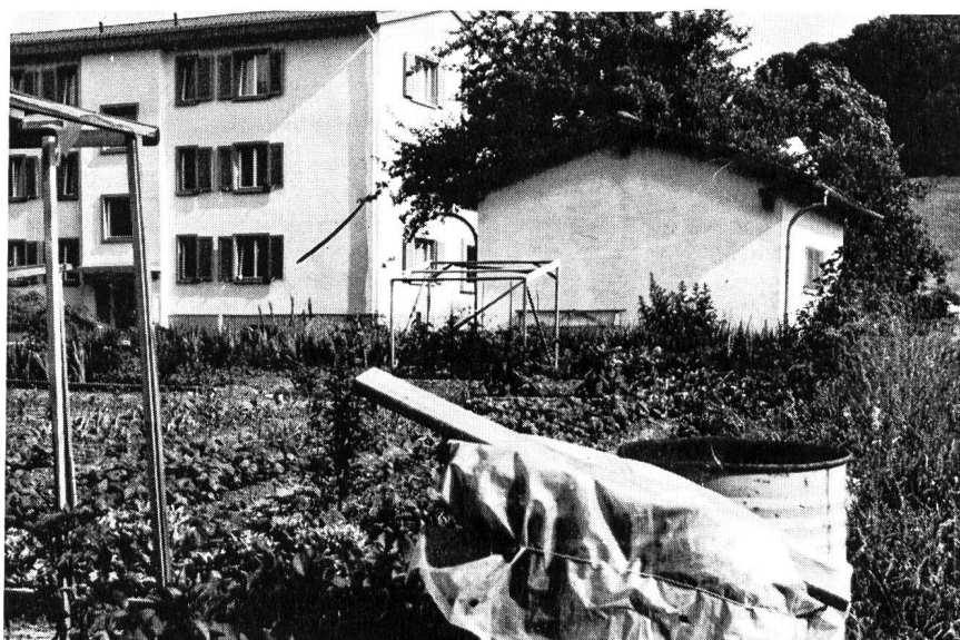
Abb. 1. Trinkwasserfassung ohne Schutzzone am Rand eines Wohngebiets. Eine Gemeinde hatte vor 25 Jahren in einer angemessenen Schutzdistanz von dem damals talaufwärts noch 150 m entfernten Baugebiet ein Grundwasserpumpwerk erstellt. Da keine Schutzzone ausgeschieden wurde, ist heute das Baugebiet mit Wohnhäusern und Gemüsegärten bis in die unmittelbare Nähe des Pumpwerks vorgerückt
