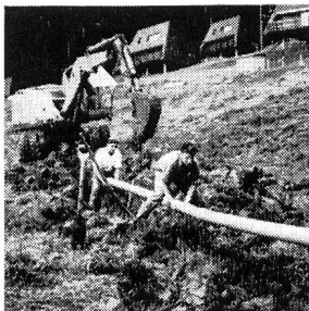
Kanalisation Schwyz: Rothenturm
