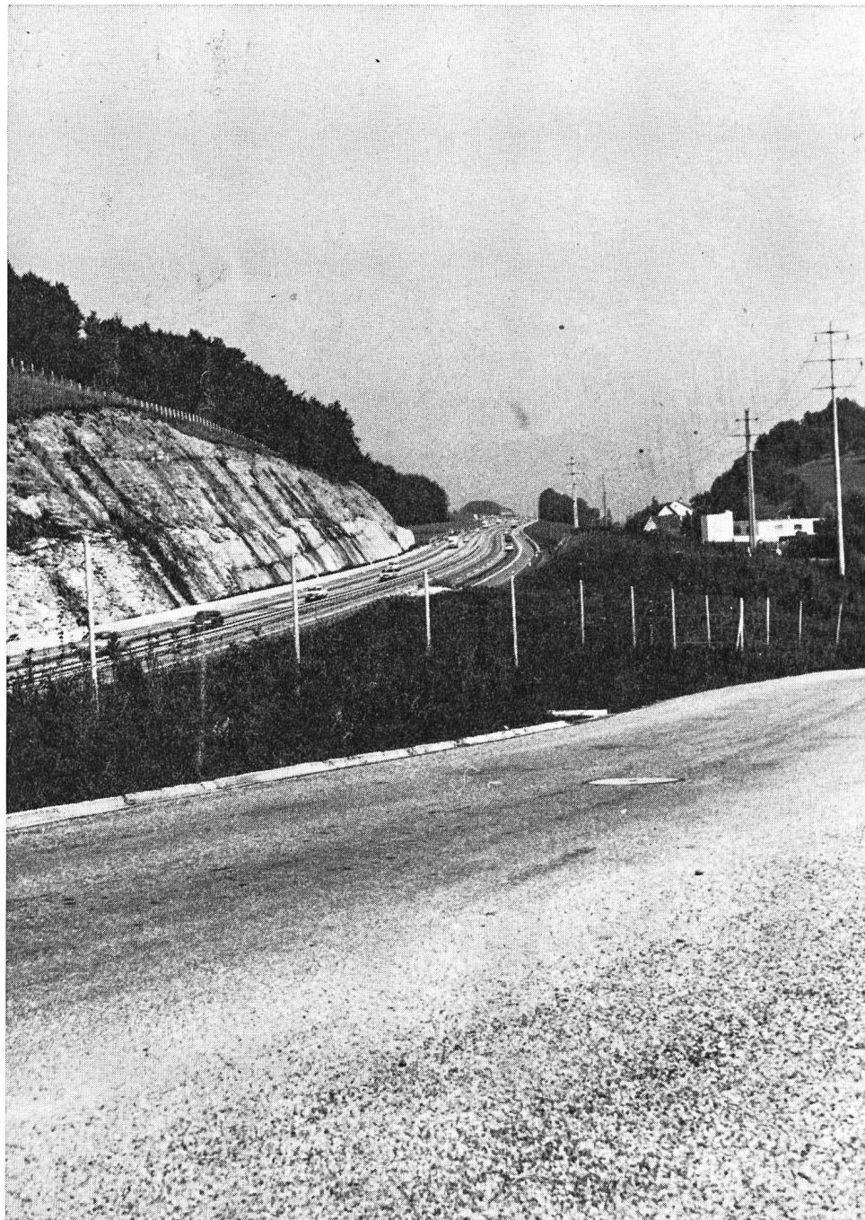
Abb. 9. Die Autobahn bei Tenniken Links der angeschnittene Hang, teilweise mit Felsbefestigungen (Grössenvergleich: Personenwagen). Die Begrünung derartiger Einschnitte dürfte einige Probleme bereiten. Zwischen Autobahn und Strasse liegt das Areal, das zur Aufforstung bestimmt ist. Mit einer solchen Kulisse kann zwischen Autobahn und Baugebiet (rechts im Bild) eine optische Trennung herbeigeführt werden. Das der Autobahn nächstgelegene Gebiet ist als Puffer der Gewerbezone zugeteilt. Ganz rechts im Bild sind Teile der Wohnzone sichtbar.
