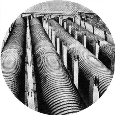
**SPIRALEEN-KANALROHRE AUS KUNSTSTOFF FÜR ABWASSERLEITUNGEN**
