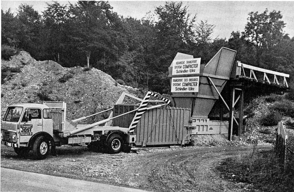
Abb. 1. Kehrriechverladestation System Compacter-Schindler-Wirz mit 20-m 3 -Container, Stopfpressanlage und Schwenklader. Fassungsvermögen des Einfülltrichters 25 bis 35 m 3
