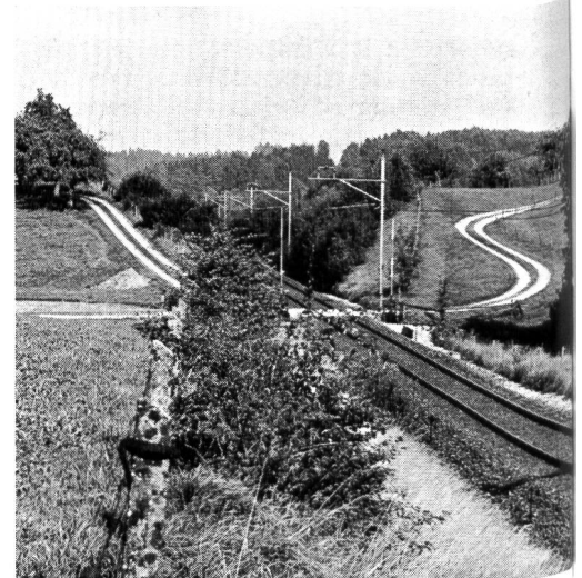
Abb. 7. Zwei verschiedene Elemente des Menschen in der Landschaft. Die Eisenbahn, an geringe Gefälle gebunden, «durchschneidet» das Gelände; die Flurstrasse, die nur wenig Erdbewegung erlaubt folgt elegant den Geländebewegungen (Hauptwil TG).
