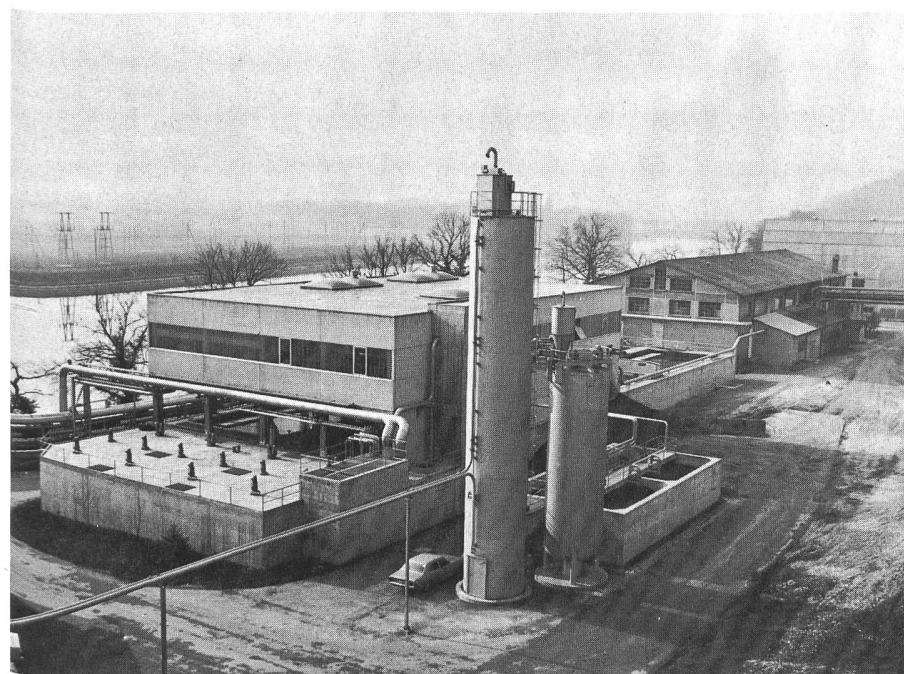
△ Cellulose Attisholz AG Mechanisch-chemische Abwasserreinigungsanlage MEKA
