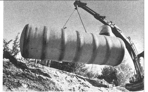
Der korrosionssichere S+O-Heizöltank aus glasfaserverstärktem Polyester
