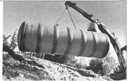
Der korrosionssichere S+O-Heizöltank aus glasfaserverstärktem Polyester
