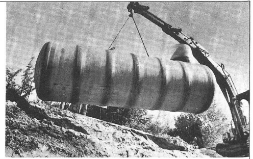
Der korrosionssichere S+O-Heizöltank aus glasfaserverstärktem Polyester
