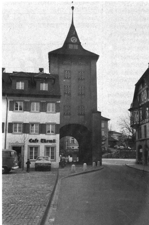
Stadttor: 1979 wurde die Tordurchfahrt für Autos gesperrt. Der angrenzende Neubau wurde ebenfalls 1979 fertiggestellt.
