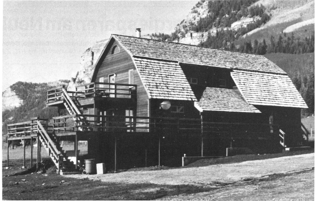
Nord- und Ostfassade – alle notwendigen Zugänge sind der Strasse zugewandt
