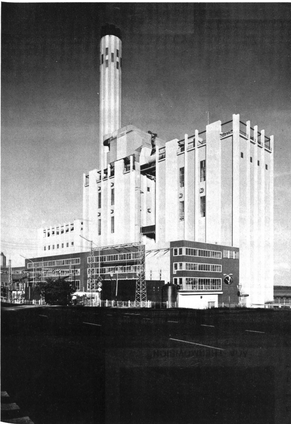
Fernheizkraftwerk Västerås, Schweden, mit zwei Sulzer-Einrohrdampf- erzeugern, Leistung je 890 t/h bei 190 bar und 540/540°C.
