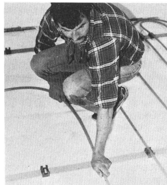
Die Unitex-Fussbodenheizung wird im Schnellsteckverfahren verlegt.
