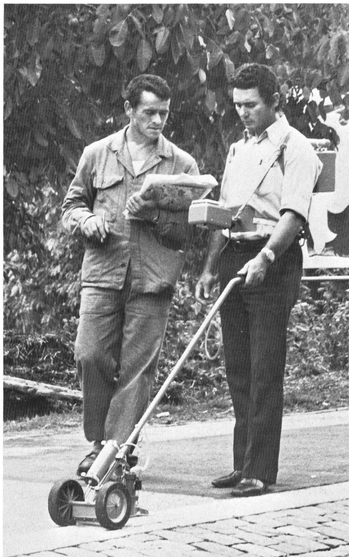
Gaslecksuche mit speziellem Suchgerät, das Gaskonzentrationen von 1:10000 unter dem Strassenbelag feststellen kann.
