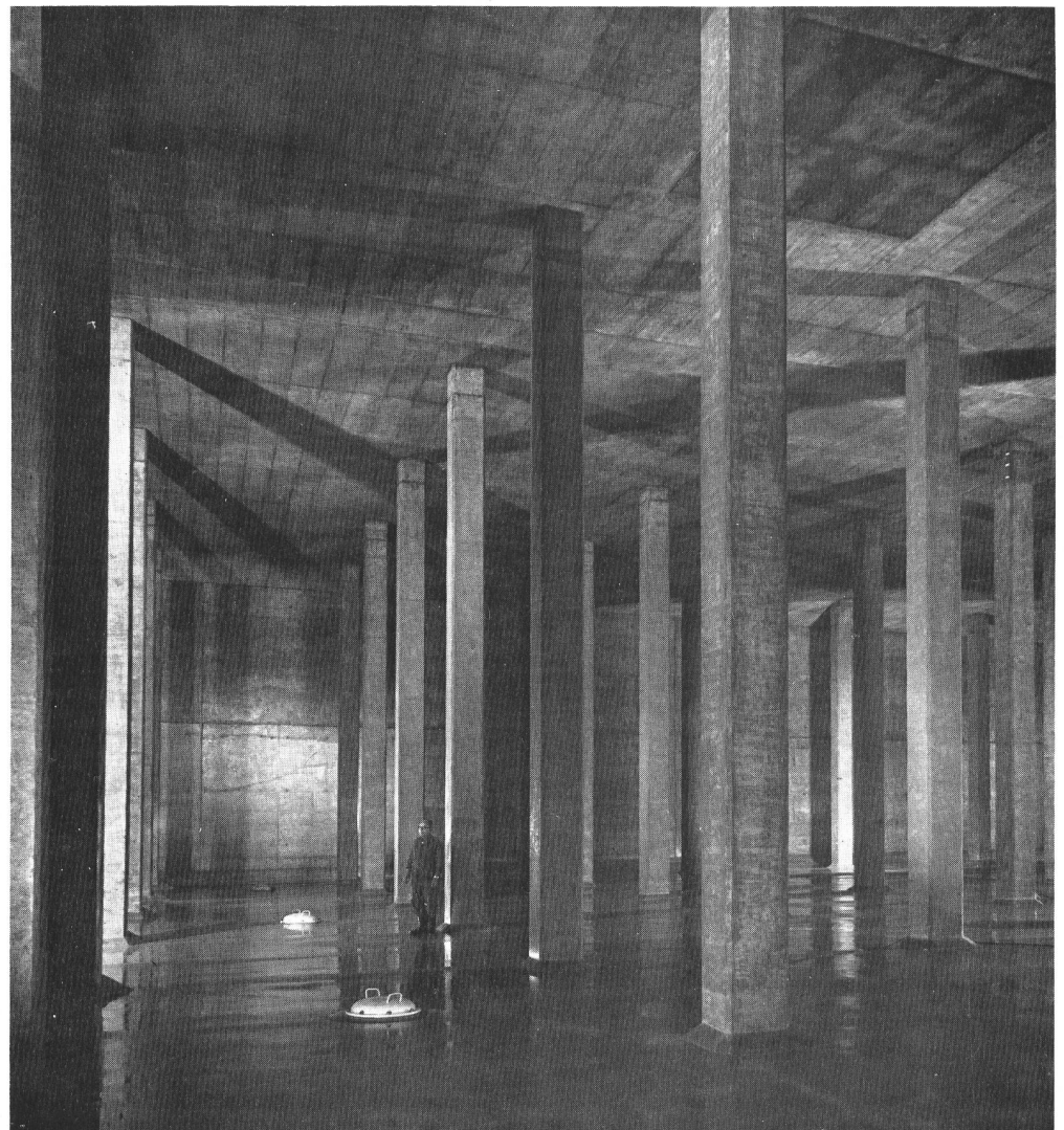
Abb. 5. Reservoir Lyren, Innenansicht einer Kammer mit 10000 m 3 Inhalt.
