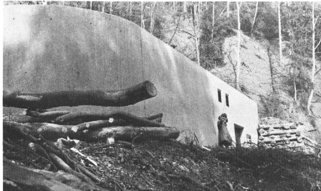
Abb. 14. Reservoir Ris (1981), fertiggestellte Anlagen mit braungefärbter, gestockter Sichtbeton-Fassade.
