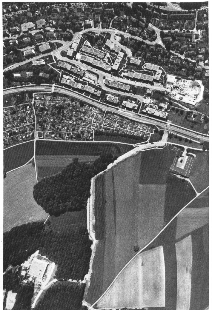
Abb. 10. Reservoir Höngg in der Wohnzone, Baustelle im Flugbild, die umliegende Überbauungsstruktur ist sichtbar.
