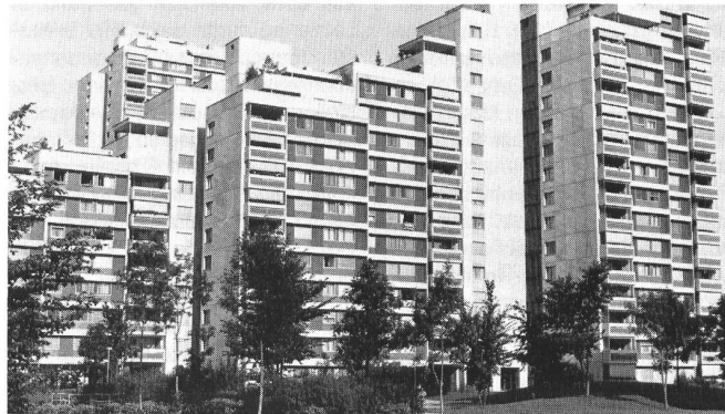
Überbauung im Murifeld, Bern, mit total 268 nachträglich eingebauten Fortluftautomaten.
