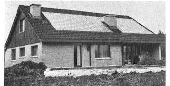
gibt es in der Form passgenaue Kloeber-Acrylglasziegel. Das sturmsichere Verlegen bietet dank der Befestigungsklammern keinerlei Schwierigkeiten. Gemäss EM-PA-Prüfbericht Nr. 1433244/1 vom 12. April 1979 entsprechen die Kloeber-Acrylglasziegel der Brandklassenziffer IV/3.
