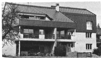
Mehrfamilienhaus in Kilchberg mit 160 m 2 Sessa-Therm-Elementen im südseitigen Steildach und in der Fassade.
