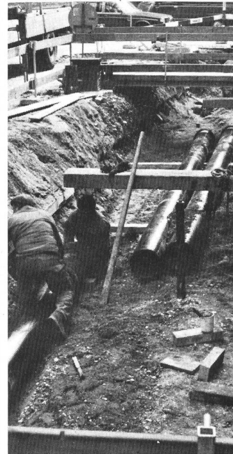
Neuverlegte Leitungen.
