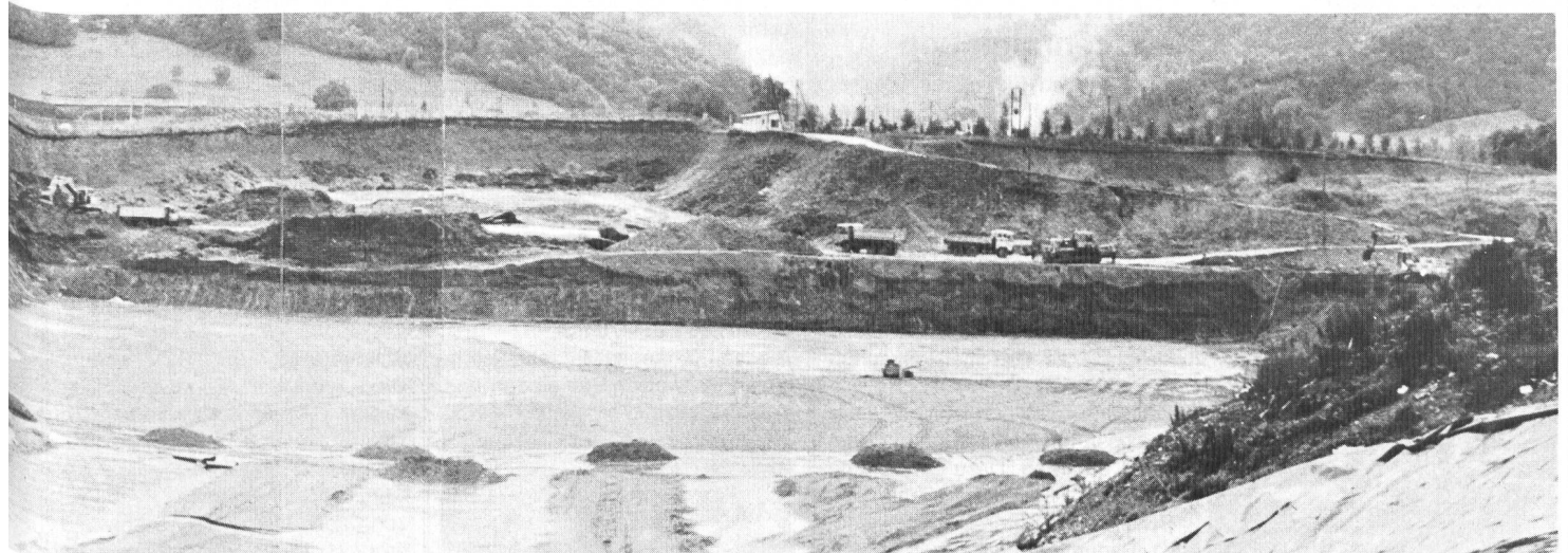
weisser Streifen) verlegt. Im Mittelgrund Sandhaufen und -lagen zur Beschwerung der verlegten Abdichtung. Anschliessend wird der Sand in der Stärke von 10 cm als Schutzschicht gegen Beschädigung (Durchstossen) ausgebreitet. Im Hintergrund noch Tiefbau-(Aushub-)Arbeiten (Bagger und Transportfahrzeuge). In Bildmitte hinten das Waaghaus = Standort der Aufnahmen der Abbildungen 1 und 9. Zeit der Aufnahme: Mitte August 1981.
