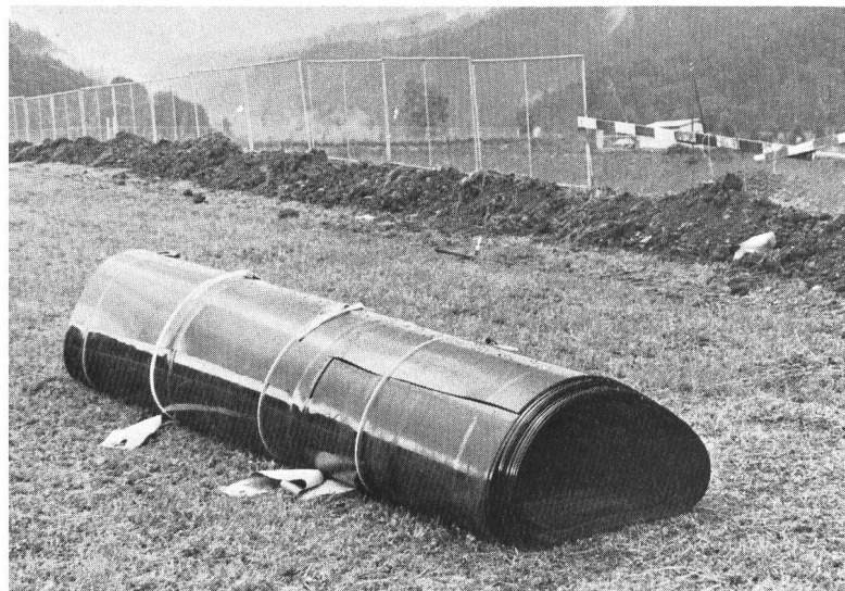
Abb. 5. Bereitgelegte Rollen Sarnafil P 2 mm stark aus HDP. Für das Ablassen der KDB vom Böschungsrund nach unten werden werkseitig Bänder eingerollt.
