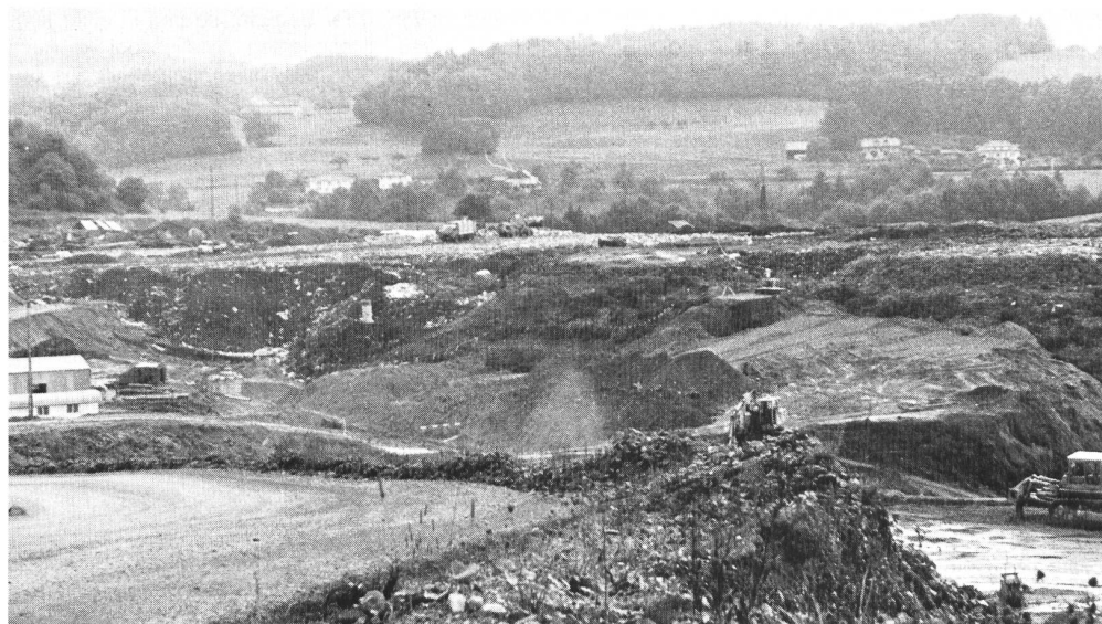
Abb. 1. Blick von der Verbindungsstrasse Châtel-St-Denis nach Montreux auf den schon gedichteten (Etappe 1 und 2) Teil der gesicherten Deponie. Auf dem gelagerten Müll die Müllverdichter in Aktion.
