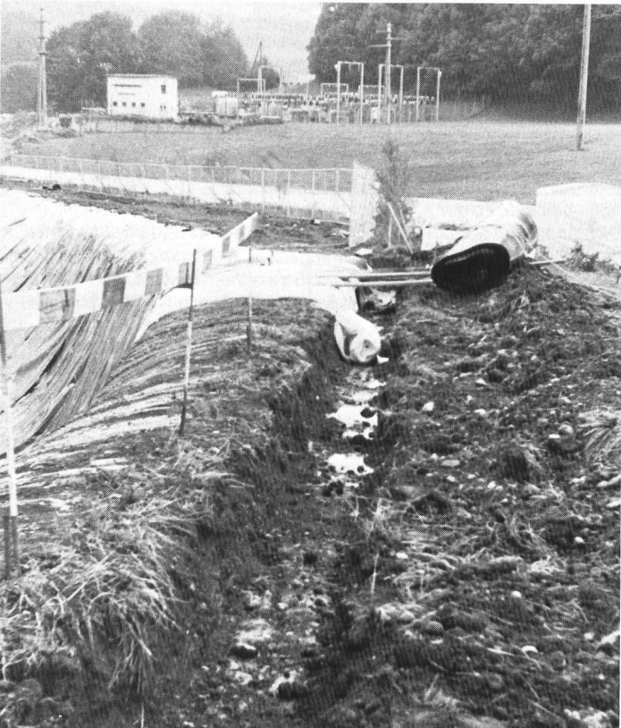
Abb. 7. Das Geotextil Bidim wie auch die KDB Sarnafil werden zusammen in einen auf der Böschungskrone ausgehobenen Graben eingelegt und verankert. Der Graben wird anschliessend zugefüllt.
