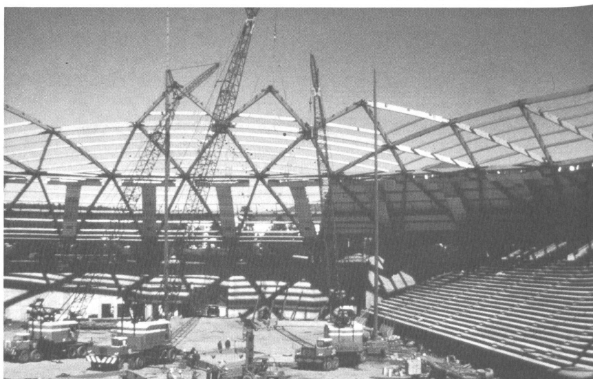
Abb. 8. Die leicht anzutransportierenden Elemente werden mit Kranwagen und mit wenigen Hilfsstützen im Freivorbau montiert. Die Zwischenpfetten werden im Takt eingehängt, damit die nachfolgende Schalung befestigt werden kann.
