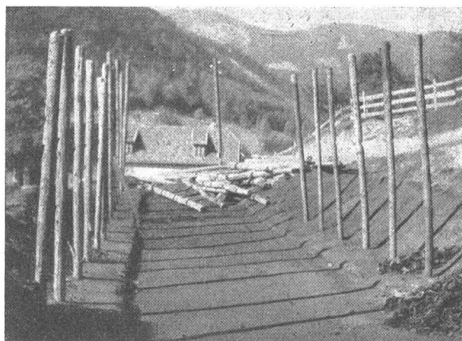
Abb. 2. Hier wird ein „Kohlhaufen“ angelegt. Die „Steher“, Pfähle, zwischen denen das Holz aufgeschichtet wird, bleiben auch nach dem Abräumen für den nächsten Meiler stehen
