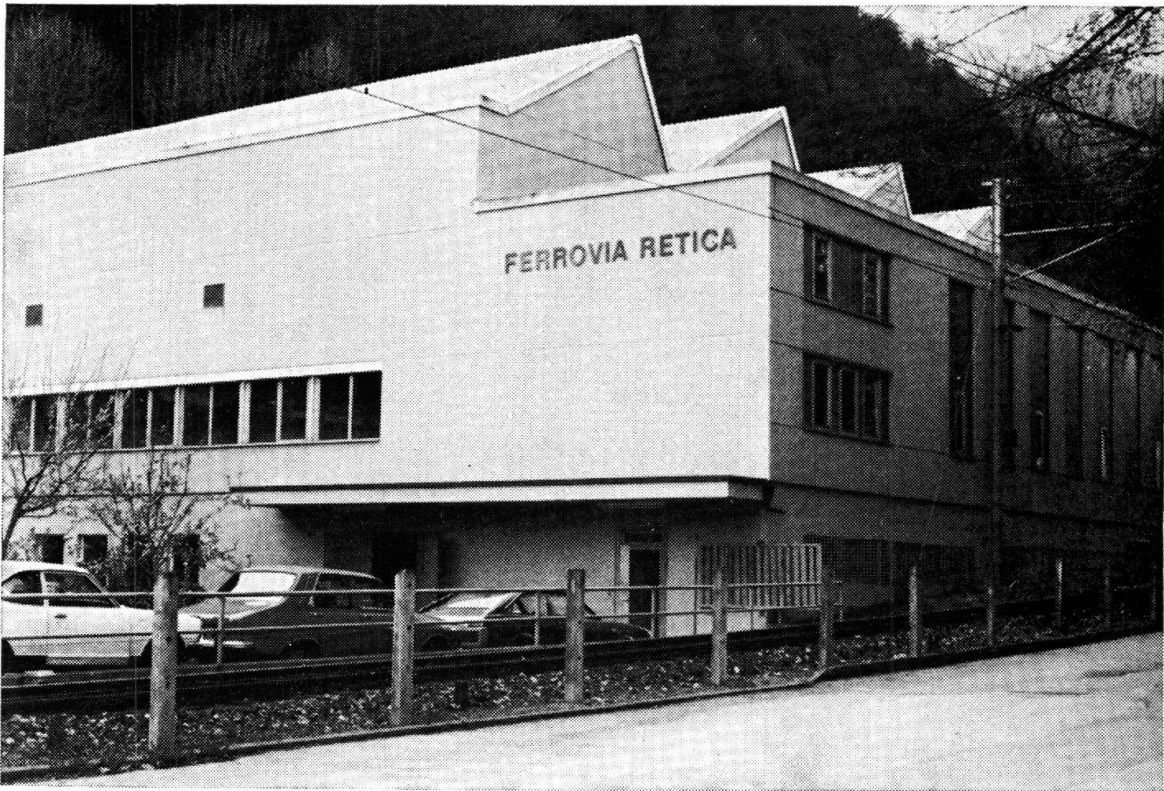
nuovo deposito della Ferrovia retica
