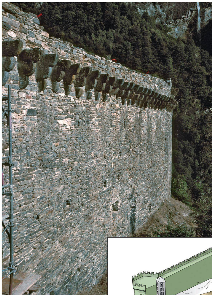
Ill. 22 - Mensole in sasso sporgenti («Maschikuli») verso il camminamento di difesa dopo il 1480 (fotografia Servizio archeologico dei Grigioni)
