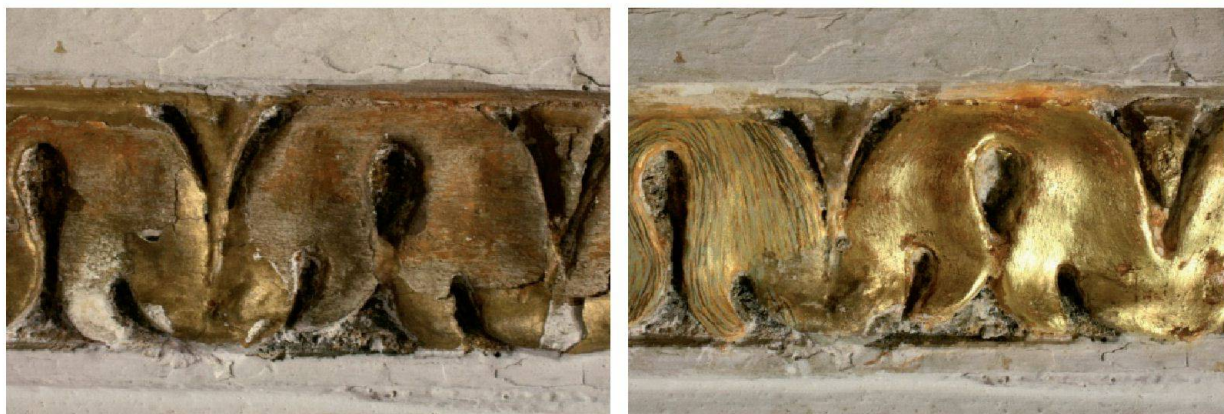
Fregio in stucco prima e dopo l'intervento di restauro della doratura.
