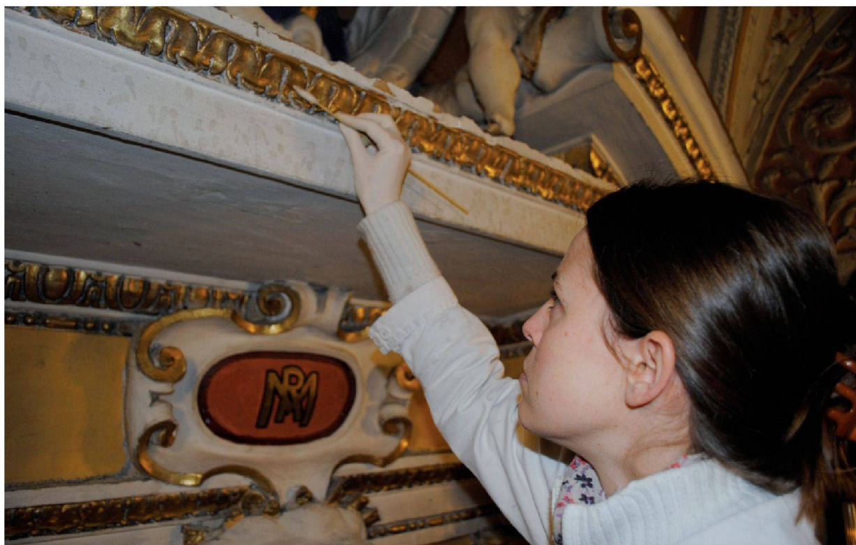
Pulitura della doratura a guazzo originale tramite tamponi con acetone
