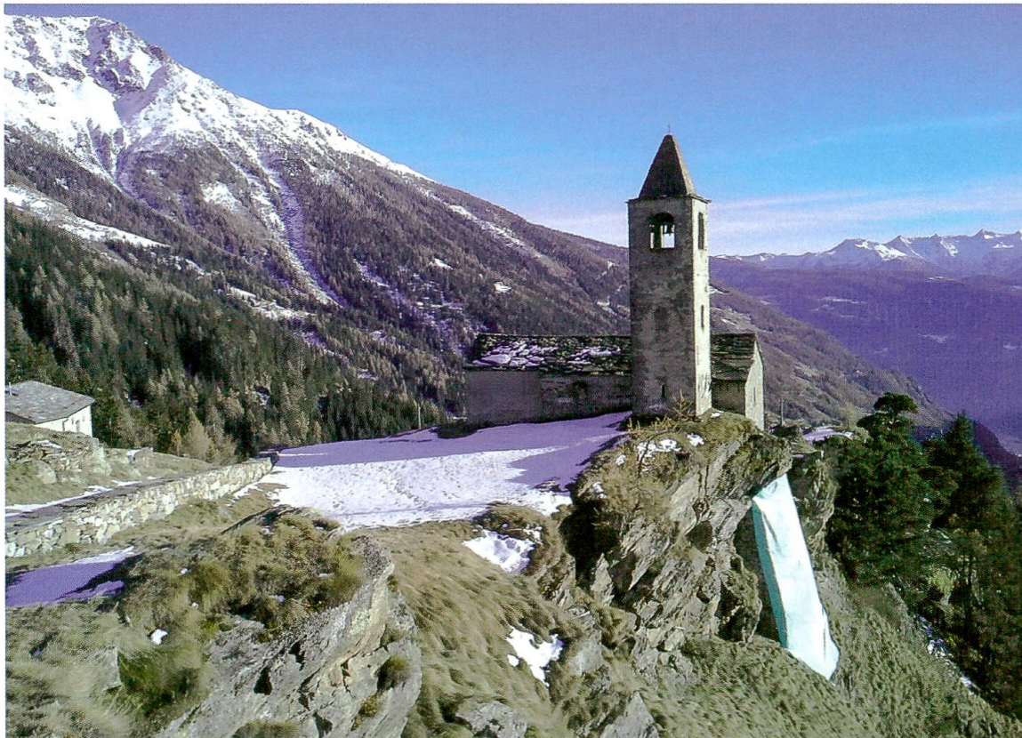
La posa del telo di protezione
