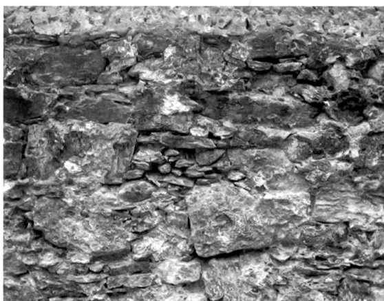
Muro posteriore (particolare)
