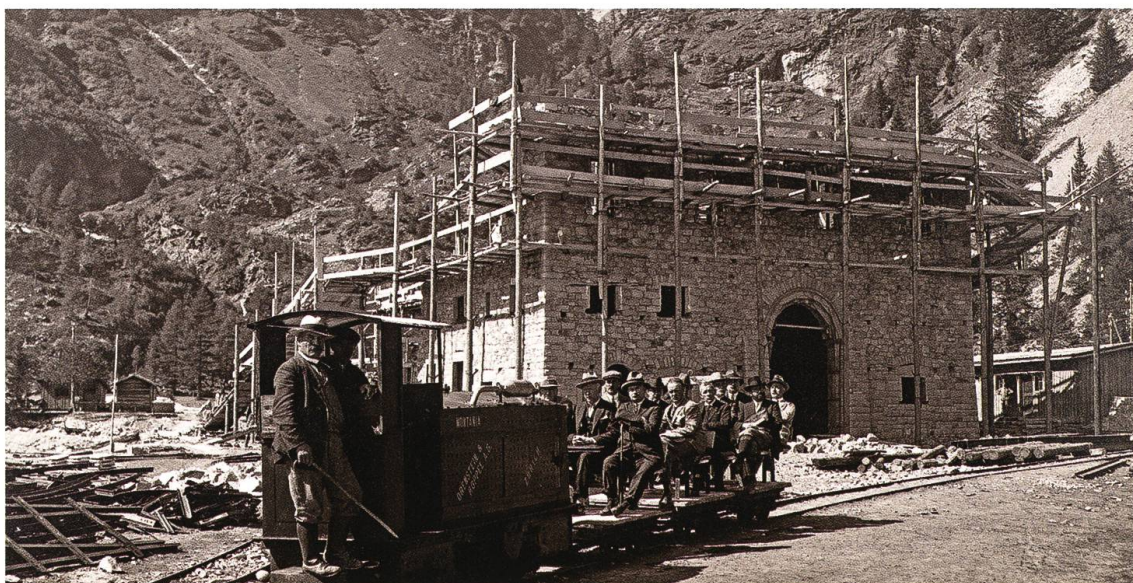
La centrale di Cavaglia in costruzione, 1926. Fonte: Archivio Repower
