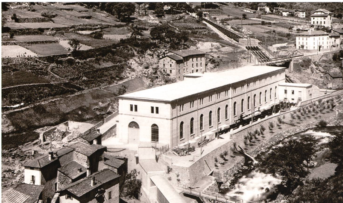
La centrale di Campocologno, 1906. Fonte: Archivio Repower
