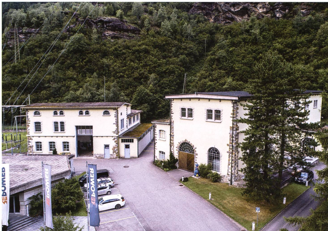
La centrale di Robbia in fase di rinnovo, 2020. Fonte: Archivio Repower
