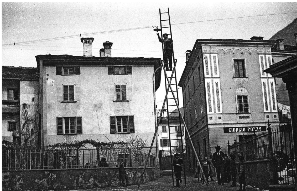
Sostituzione di una lampadina in Via da Mezz a Poschiavo, 1900. Fonte: Archivio Luigi Gisepp – Società Storica Val Poschiavo
