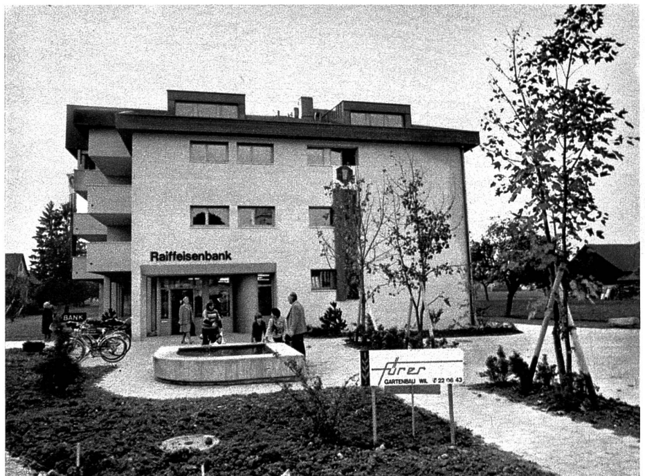
Neubau der Raiffeisenbank Oberbüren
