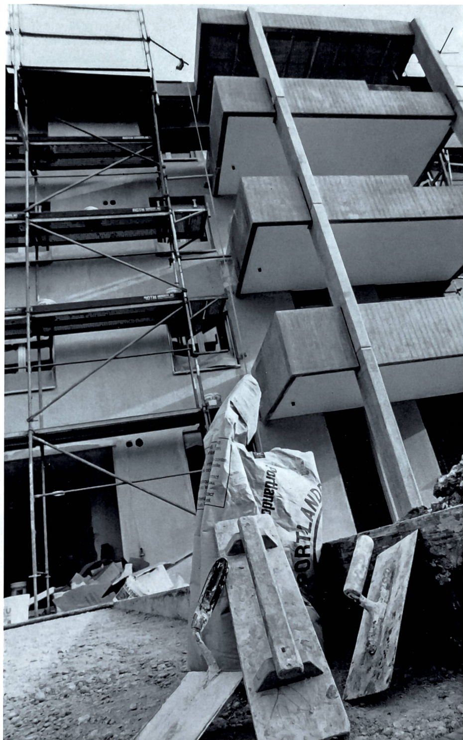
Neue Wohnungen sind nicht mehr kostendeckend zu vermieten.
