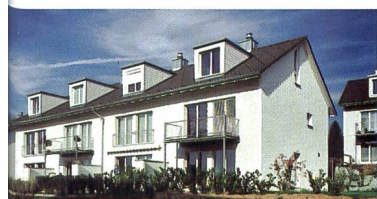
Rohbau in hoher Qualität – einfach gehaltener Ausbau, der später erhöht werden kann (Peikert Econom-Haus).
