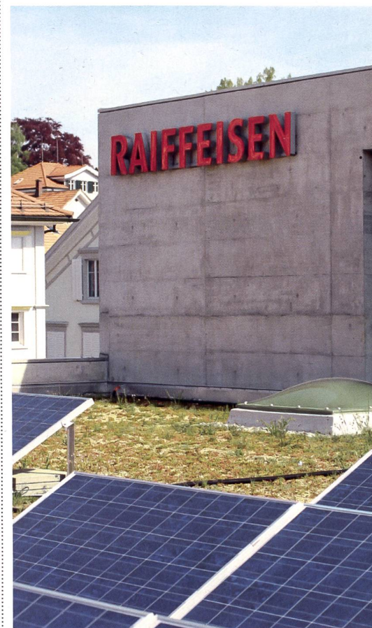
Die von der Photovoltaik-Anlage der Raiffeisenbank erzeugte Energie reicht für die Stromversorgung von drei Einfamilienhäusern.
