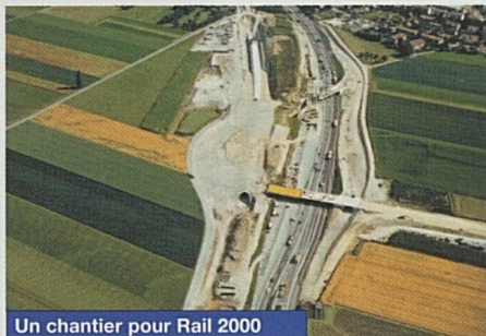
Un chantier pour Rail 2000
