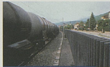
Mise en œuvre rapide des mesures visant à réduire le bruit du chemin de fer.
