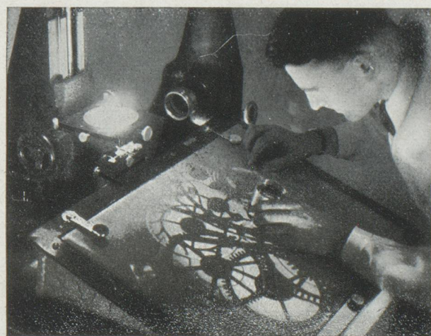
Contrôle de la marche des montres à l'Observatoire de Neuchâtel Le projecteur de profils
