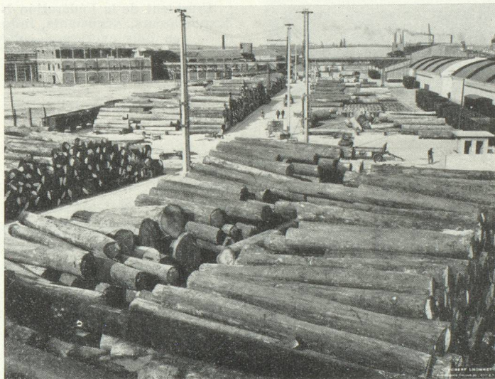
Le parc à bois coloniaux dans le port du Havre
