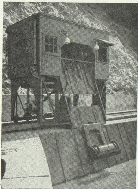
Râteaux mécaniques et appareils
