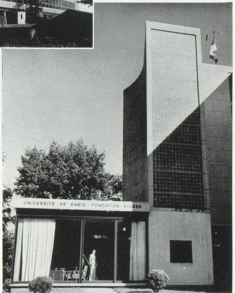
LE CORBUSIER : entrée du bâtiment de la Fondation suisse à la Cité universitaire de Paris.
