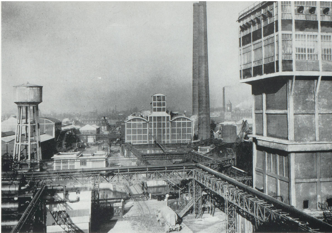
Établissements Kuhlmann : usine de La Madeleine : vue générale.
