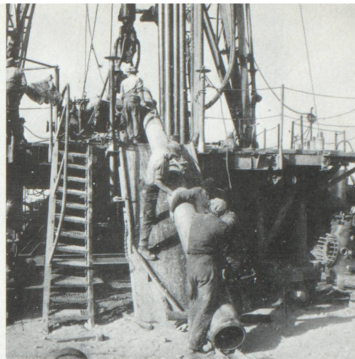
Préparation du matériel nécessaire à la descente d'un tubage (appareil de forage « Unit RIG 15 » moyen) (Cliché B. R. P.)
