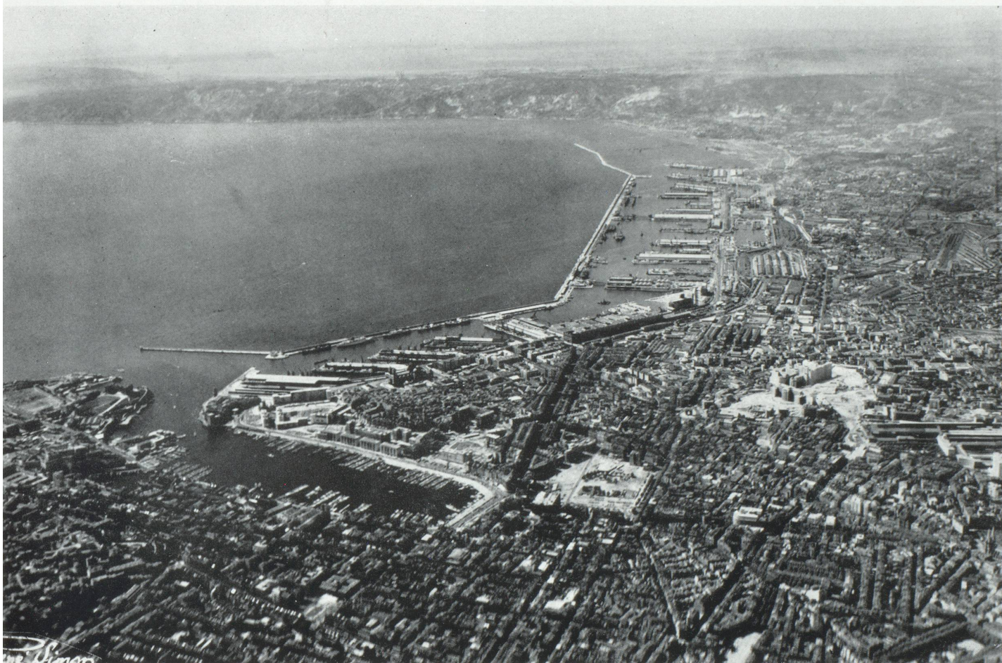
Vue aérienne du port de Marseille.
