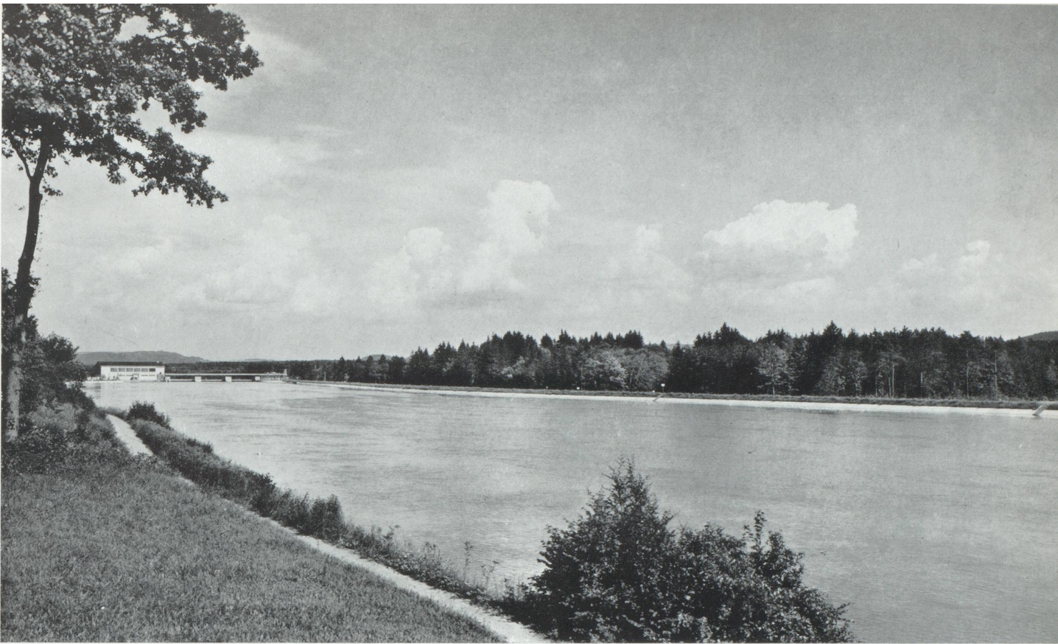
L'Aar en amont de l'usine de Rapperswil-Auenstein.
