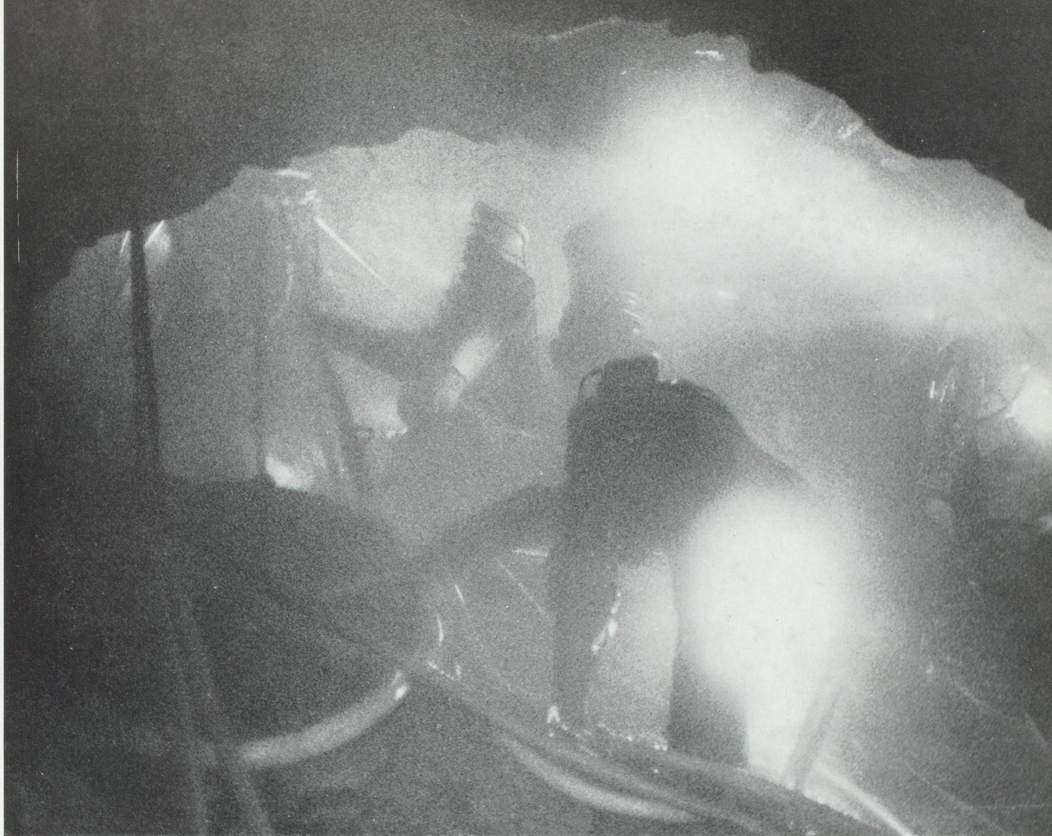
Chantier de montagne pour l'installation d'une usine électrique.
